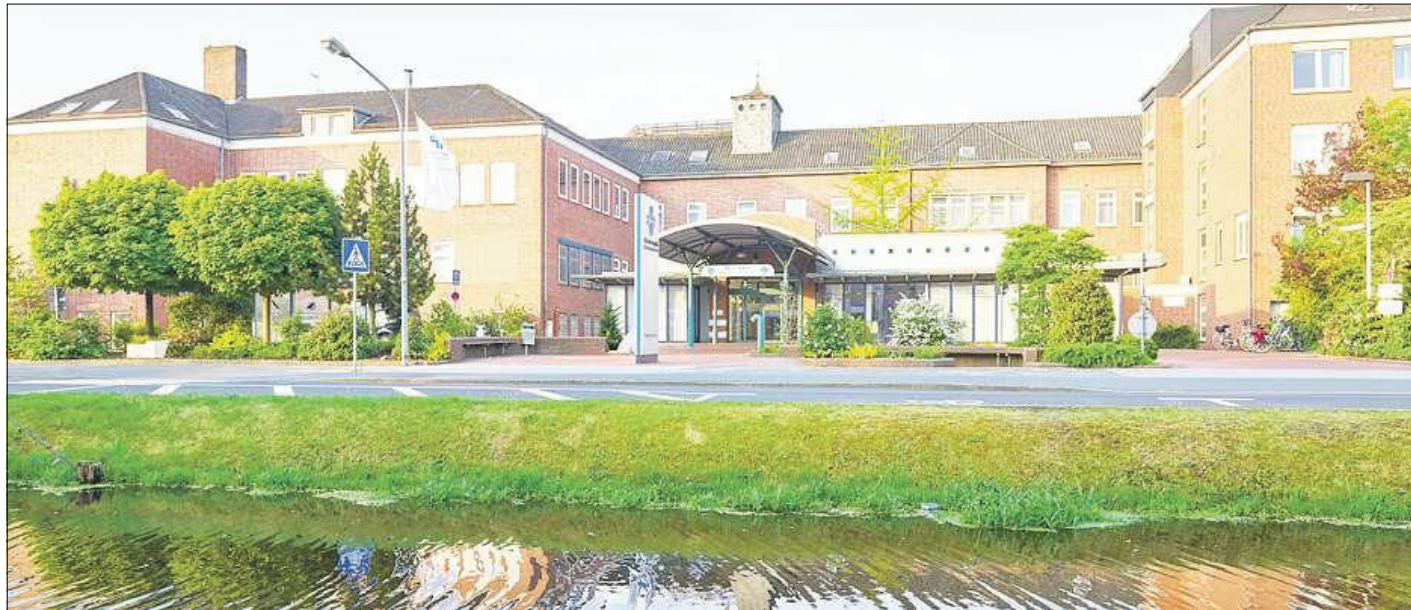
Das Marien Hospital in Papenburg soll umfangreich umgebaut werden. Unter anderem soll der Haupteingang vom Hauptkanal zum Marktplatz verlegt werden.
